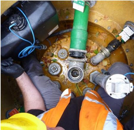
Les feux dans les chambres étanches sont plus rares que les feux lors du dépotage; ils peuvent toutefois survenir pendant une inspection, une intervention de réparation ou d'entretien, lorsque la chambre reçoit des déperditions et des vapeurs de carburant. Les objets chargés à l'intérieur de la chambre peuvent se décharger sur une personne pénétrant dans la chambre ou sur les outils qu'elle porte et enflammer l'atmosphère.
